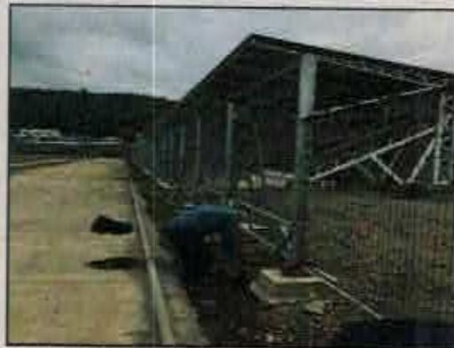
N° 28: Excavación fundaciones cerco cierre cancha sector graderías existentes.
