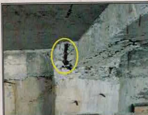
N° 9: Viga y pilar con enfierradura a la vista, ubicados en graderías en el eje G con eje 5.
