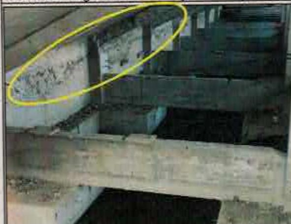
N° 11: Pérdida de estanqueidad de moldajes, en muros de hormigón armado de graderías, ubicados en el eje 5 con ejes A-H.
