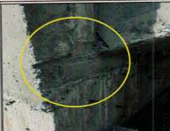
N° 14: Rebarba en pilar, viga y muro, ubicados en graderías, en los ejes I con ejes 4-5.
