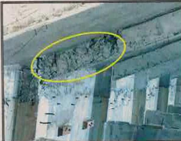
N° 19: Nido de piedras en viga y pilar en sector graderías, emplazadas en eje G entre ejes 4-5.
