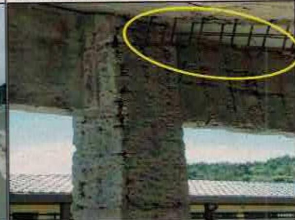
N° 24: Viga sin hormigonar en sector graderías, emplazadas en eje X entre ejes 3-5.
