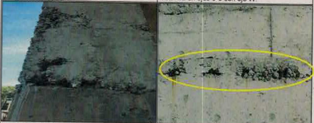
N° 17: Nido de piedras en graderías, pilar emplazado en ejes 3 con eje Z.
