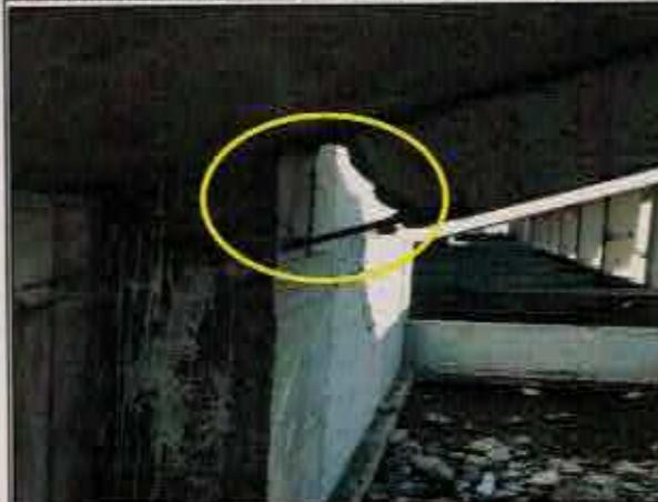
N° 21: Falta de hormigón en viga de sector graderías, comprendida entre eje S entre 4 y 5.
