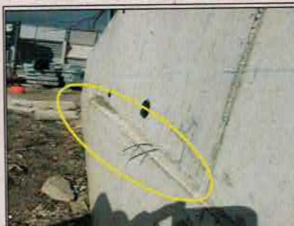
N° 13: Rebarba en muro ubicado en sector graderías en los ejes 5 con ejes C-F.
