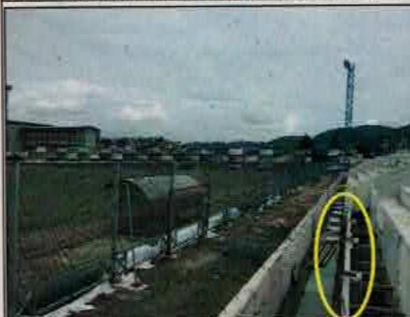
N° 23: Falta de hormigón en muro de graderías, en ejes Q-V y eje 5.
