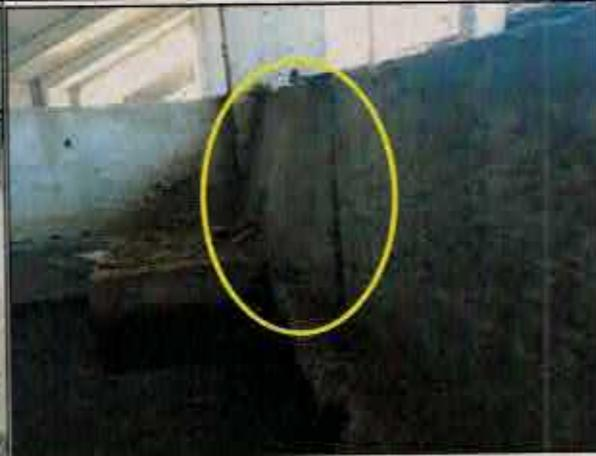
N° 12: Desaplomo en viga de fundación en sector graderías, emplazadas en eje L con eje 3.
