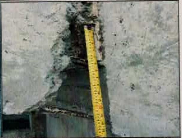
N° 20: Falta de hormigón en viga de graderías, ubicada en eje R entre 4 y 5.
